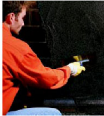
Aufziehen der kunststoffmodifizierten Bitumendickbeschichtung mit der Glättkelle.
