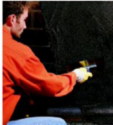
Aufziehen der kunststoffmodifizierten Bitumendickbeschichtung mit der Glättkelle.
