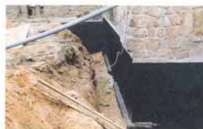
Nach Streich- und Spritzverfahren vorbereiteter Untergrund...
