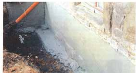
Nach Streich- und Spritzverfahren vorbereiteter Untergrund...
