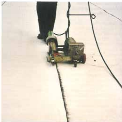
Heißluftverschweißung an den Stößen der Kellerfolie
