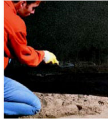
Glättziehen der Hohlkehle mit der Zungenkelle.
