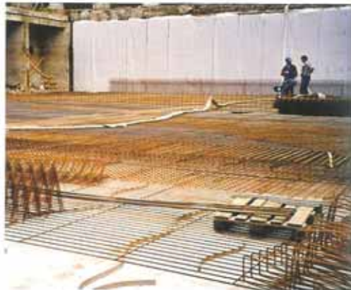
Auf dem gedämmten Bodenaufbau wird die Armierung der 1 m dicken Bodenplatte verlegt; die helle Kunststoff-Kellerfolie ist an den Wänden aufgebracht
