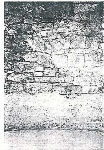
Vor dem Sanierputz: Strahlgereinigt und injiziert, dann Sperrputz, Dichtungsschlämme und Haftbrücke
