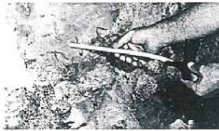
Die saugfähigen Kapillarstäbchen werden in die Bohrlöcher geschoben, die Kartuschenwinkel aufgesetzt.
