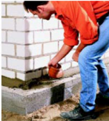
Herstellen der Hohlkehle. Querschnittsabdichtung mit Dichtschlämme.
