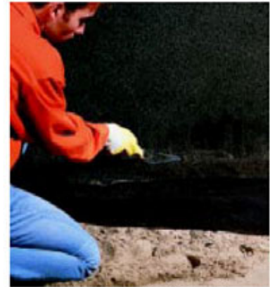
Glättziehen der Hohlkehle mit der Zungenkelle.
