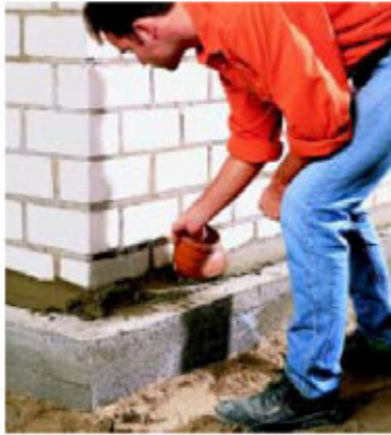
Herstellen der Hohlkehle. Querschnittsabdichtung mit Dichtungsschlämme.
